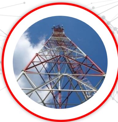
Строительство новых АМС
